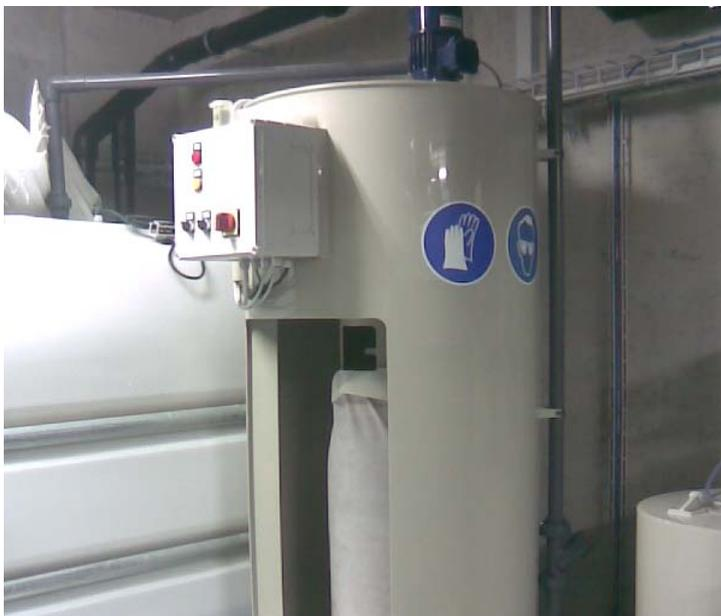
*PC 200 avec décanteur – séparateur + cuve de stockage de 2 x 2'000 litres; commande fixée sur le réacteur*
