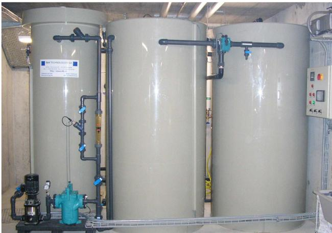
**Bioreaktor mit zylinderförmigen Arbeitsbehältern**
