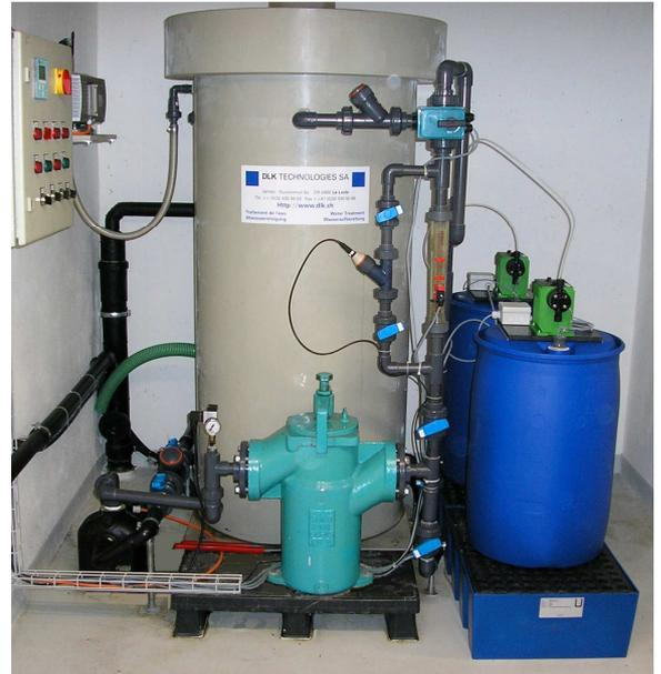
**Bioreaktor mit unterirdischen Arbeitsbehältern & automatischer pH-Wert Neutralisation, Durchfluss 2-6 m<sup>3</sup>/Tag**
