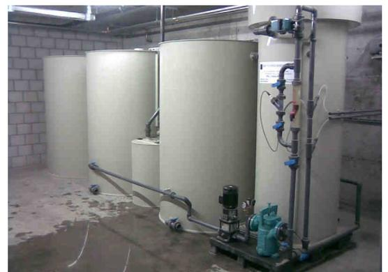
FBR Bio Standard mit Kombibehälter SF/MA, oberirdischen Arbeitsbehältern & Austrittsbehälter mit Tauchpumpe
