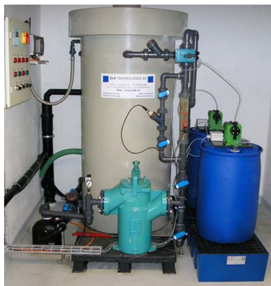
Bioréacteur avec cuves enterrées, correction automatique du pH dans les 2 sens, capacité de 2 à 6 m 3 par jour
