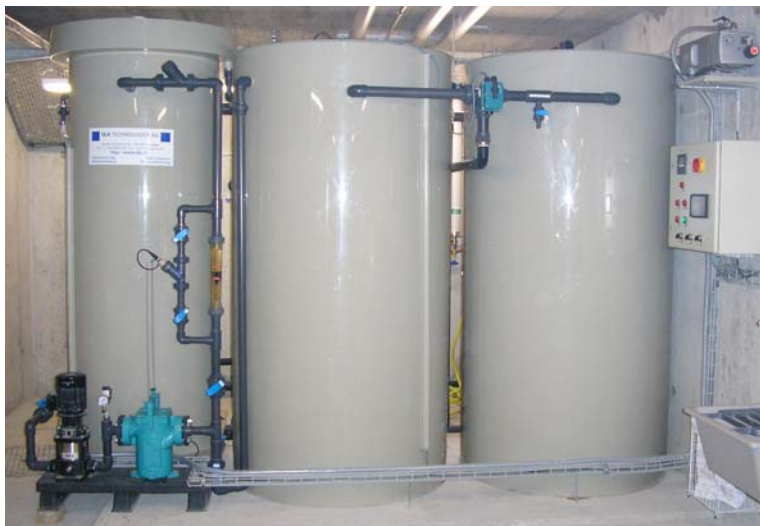
Bioréacteur avec cuves de travail cylindriques, capacité de 2 à 4 m 3 par jour
