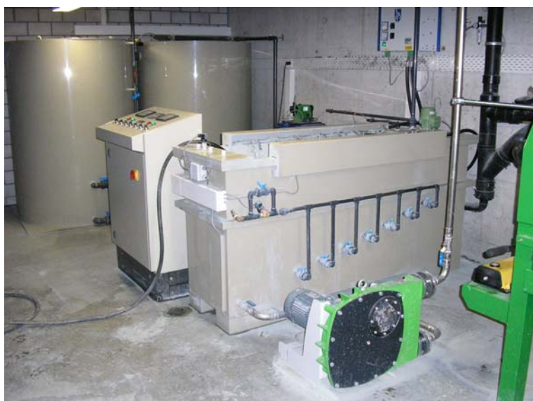
Systeme d'électrocoagulation avec pompe péristaltique
