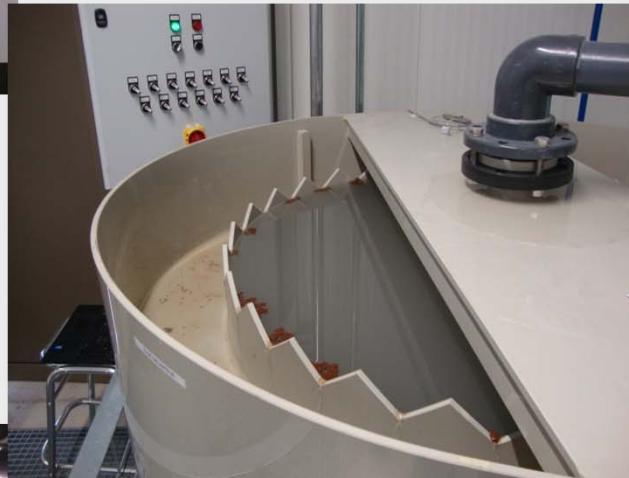
Le surverse est crénelée
